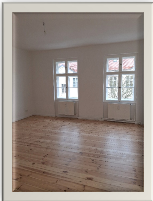
Böden werden abgeschliffen und Fenster erhalten Anstrich und Dichtung
