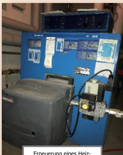
Erneuerung eines Heizkessels
